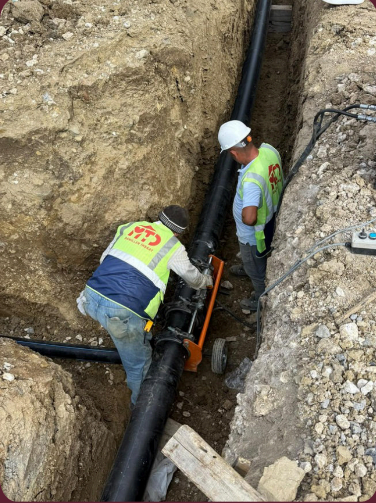
Silivri · Altyapı hattı
