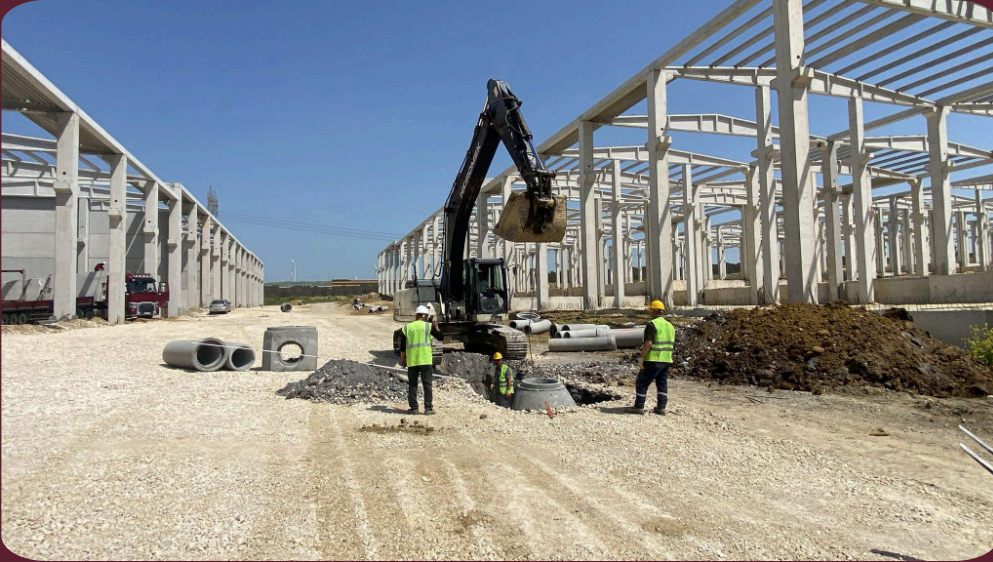
Silivri İSİLKOOP · Altyapı imalatlarımız
