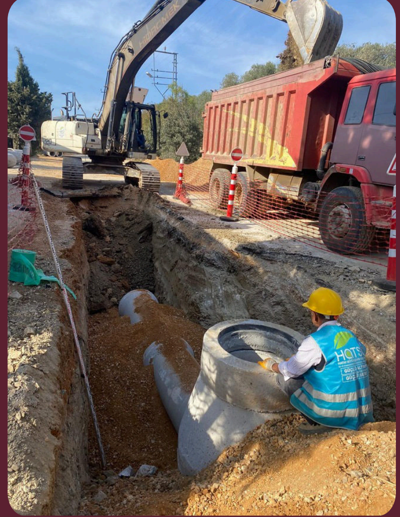
Antakya Ürgenpaşa · Kanalizasyon imalatı
