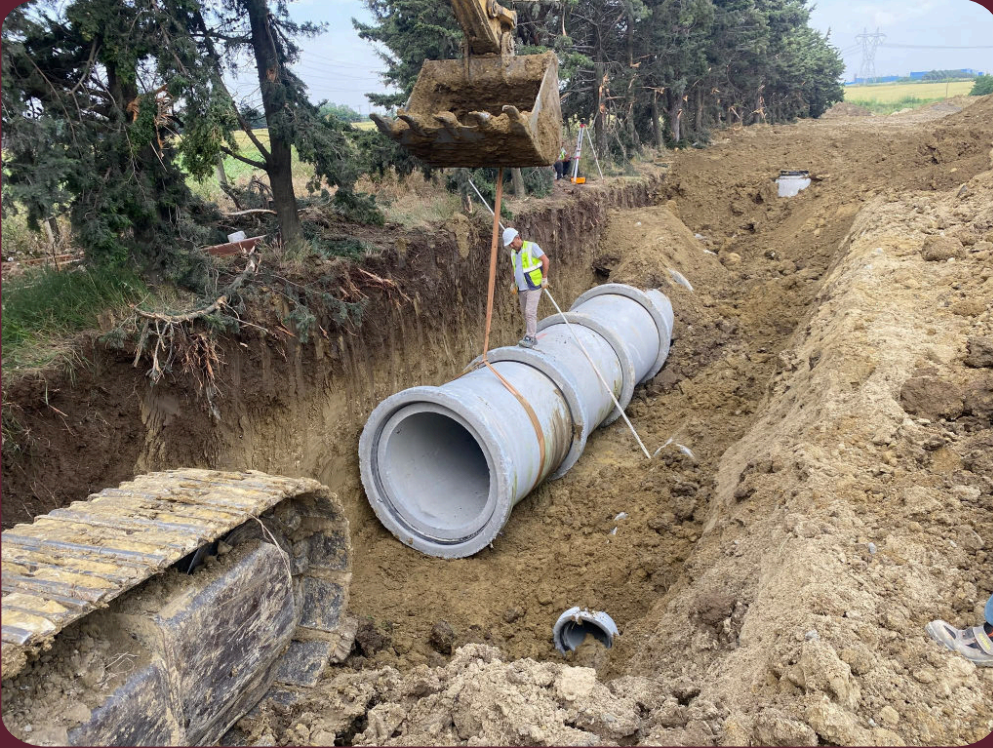
Silivri İSİLKOOP · Altyapı imalatlarımız
