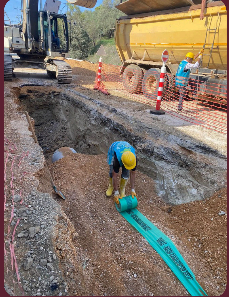
Antakya Ürgenpaşa · Boru döşeme
