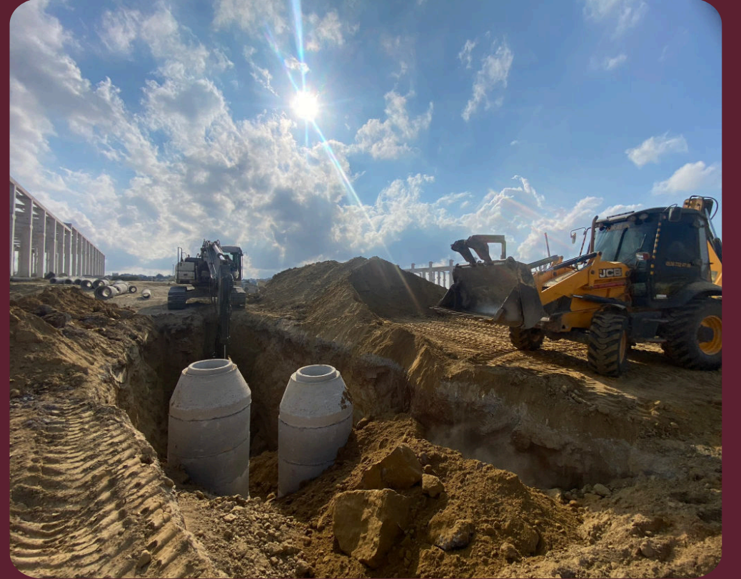
Silivri İSİLKOOP · Altyapı imalatlarımız
