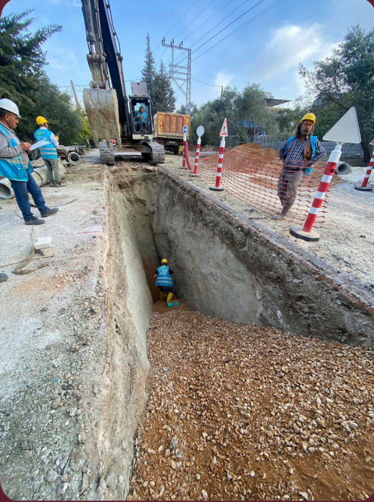
Antakya Ürgenpaşa · Kanalizasyon hattı
