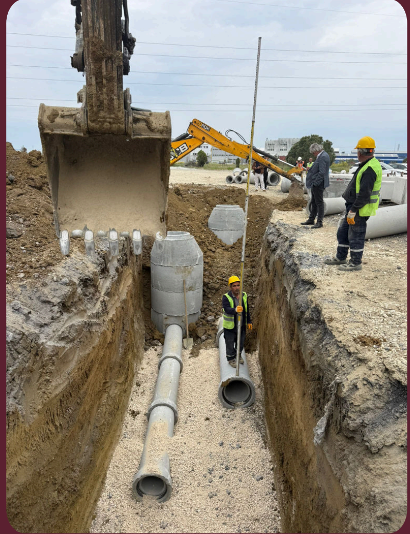
Silivri İSİLKOOP · Altyapı imalatlarımız
