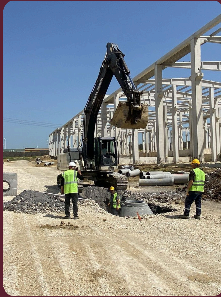
Silivri İSİLKOOP · Altyapı çalışmalarımız
