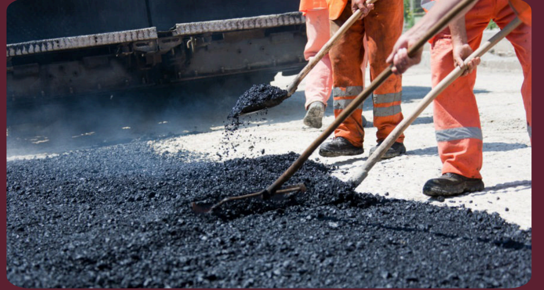
Asfalt işleri · Serim uygulaması
