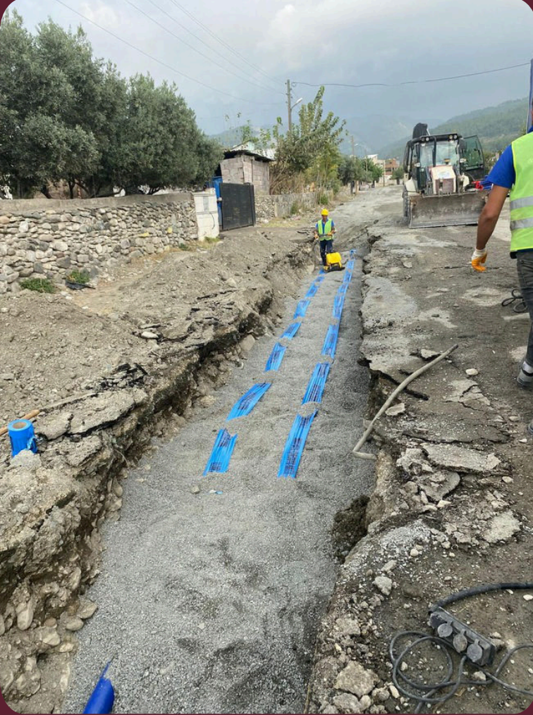
Hatay Dört yol · Boru döşeme
