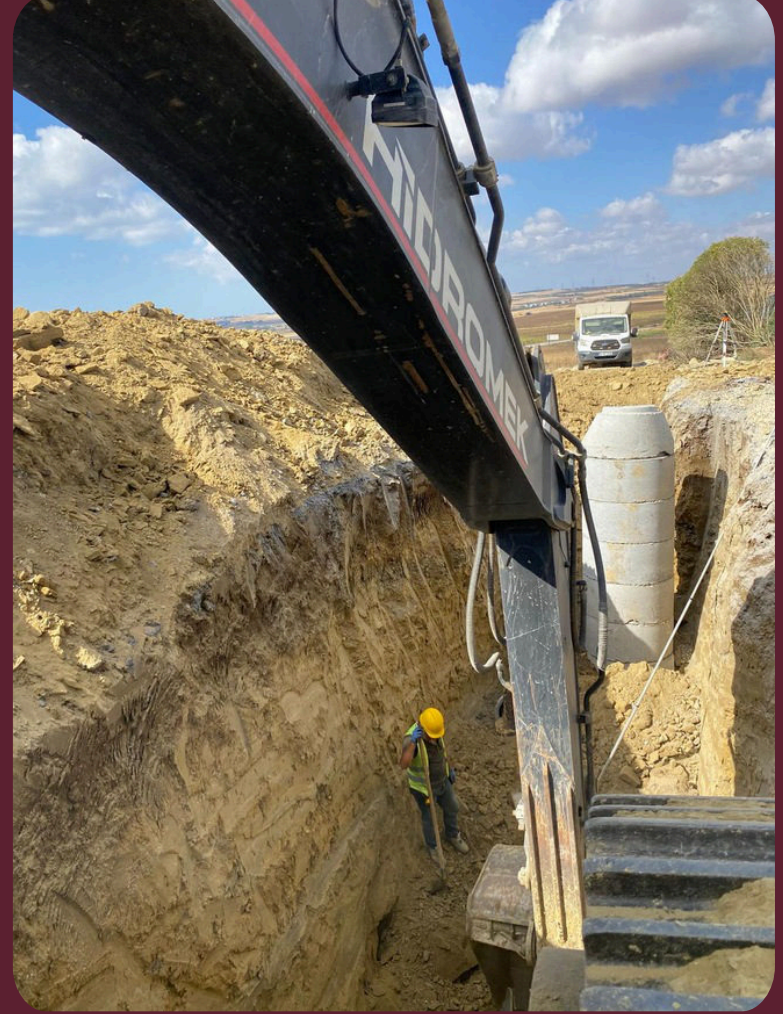
Silivri · Boru döşeme
