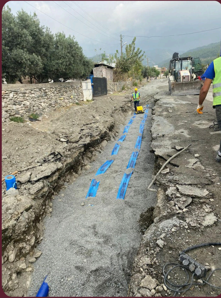
Hatay Dört yol · Boru döşeme
