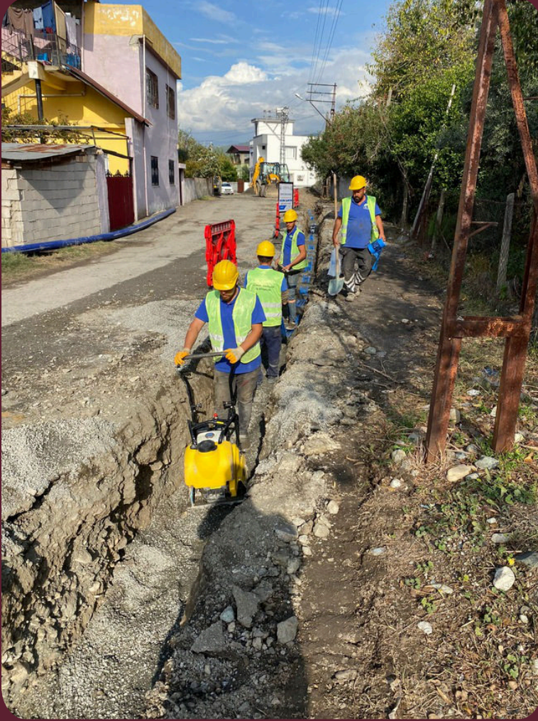
Hatay Dört yol · Hat döşeme
