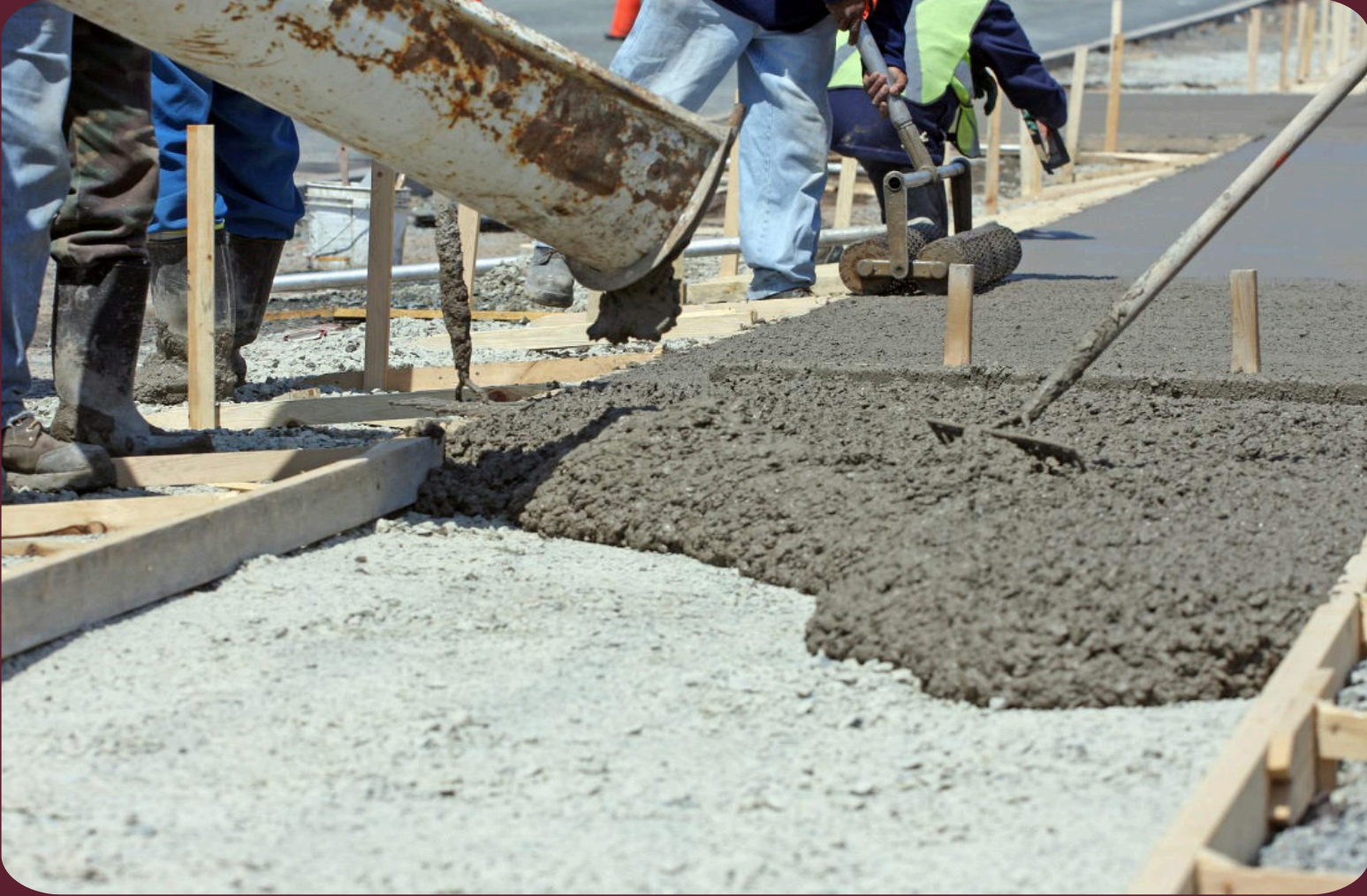
Yol işleri · Kaplama imalatı
