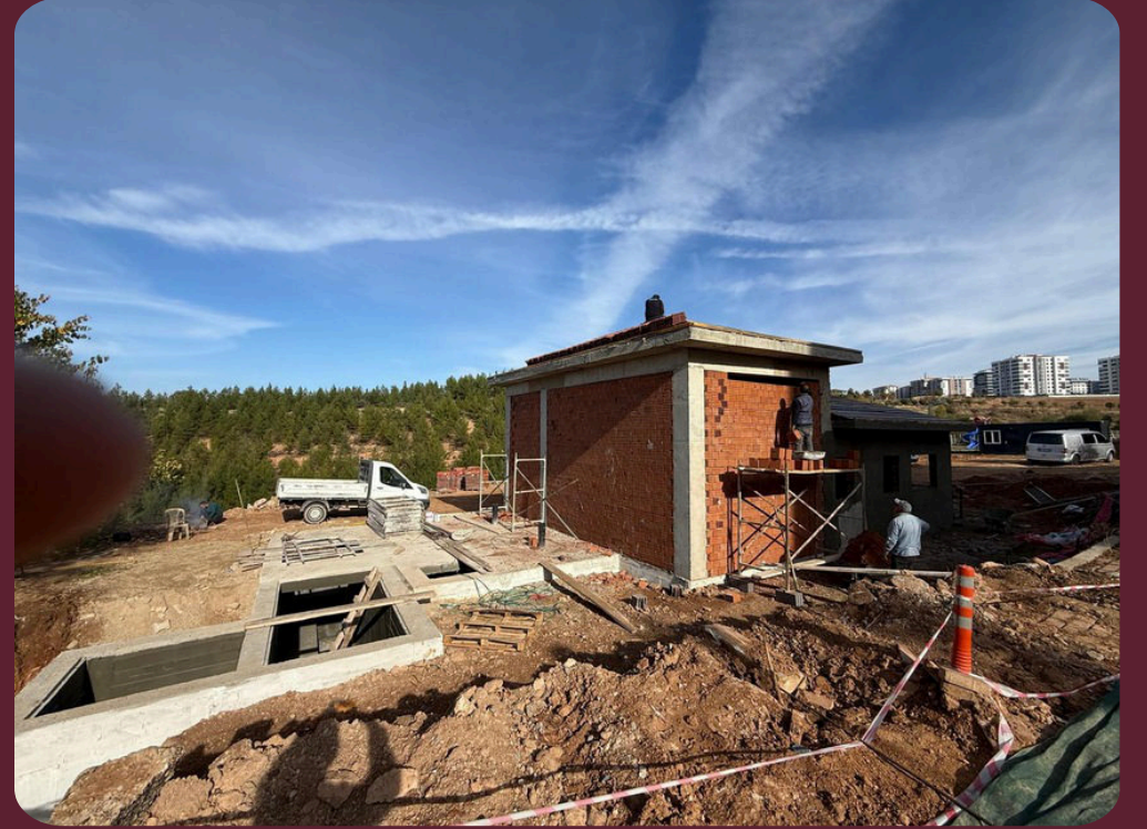
Uşak Kemalöz · Terfi merkezi inşaatı
