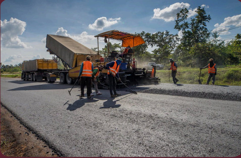
Asfalt işleri · Yol kaplama
