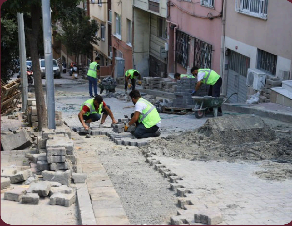
Kağıthane · Yol onarımı
